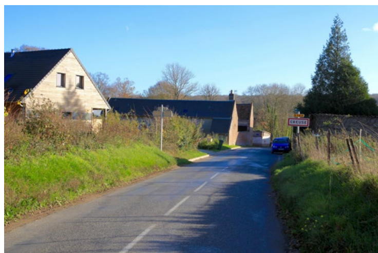
Un accès peu identifiable avec des sorties de propriétés sans visibilité et un stationnement des véhicules sur les trottoirs rendant le cheminement piétonnier très dangereux.
